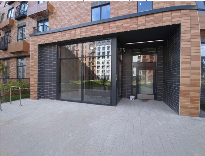
Фото №9 Внешний вид подъезда
