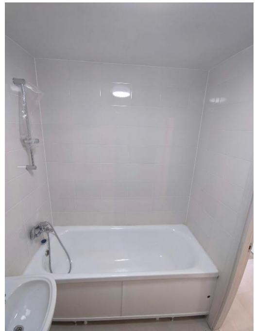
Фото №20 Санузел - помещение №2 по плану БТИ
