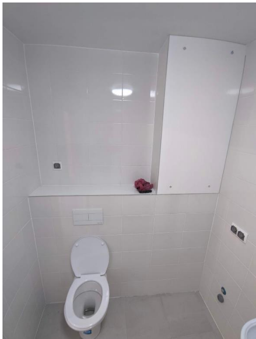
Фото №19 Санузел - помещение №2 по плану БТИ
