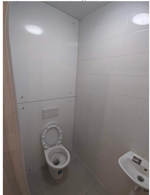
Фото №30 Санузел - помещение №6 по плану БТИ
